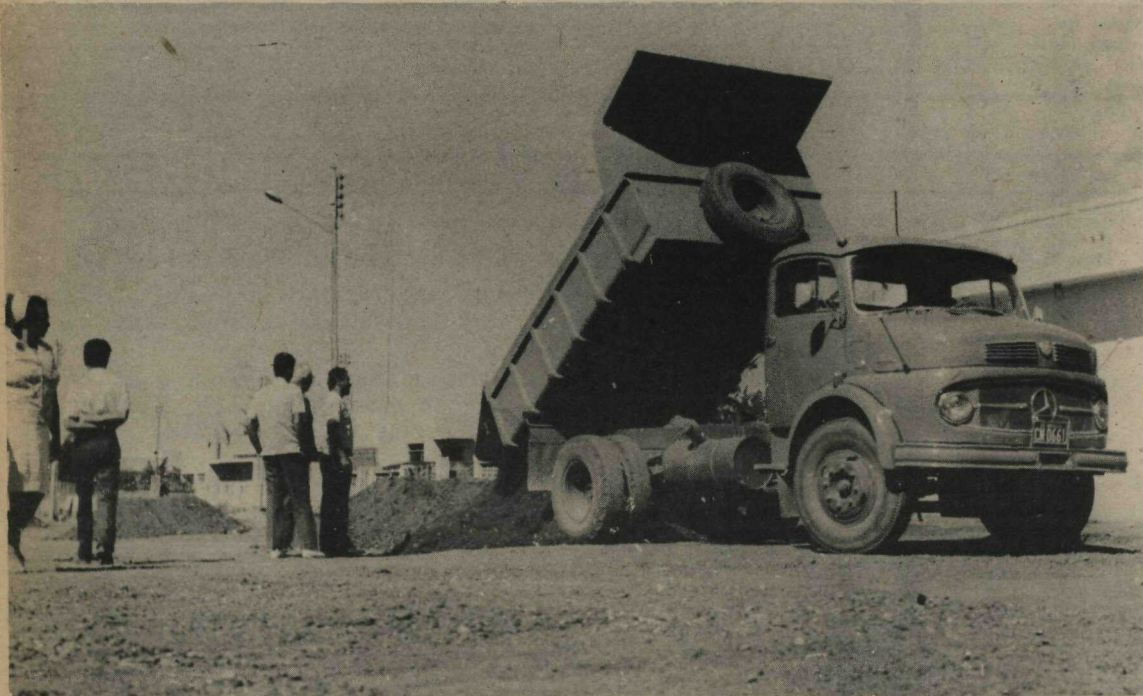
Todas as ruas internas das Quadras Norte de Taguatinga estão sendo preparadas para receberem capeamento asfáltico
