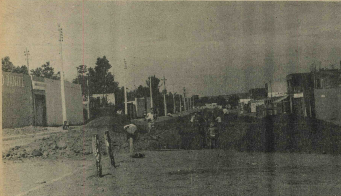
REDE DE AGUAS PLUVIAIS - Estão sendo construídos em Sobradinho vinte quilômetros de redes de águas pluviais. Iniciadas na segunda quinzena de maio, as obras estarão concluídas em novembro próximo, atingindo dois terços da área total da cidade-satélite. Várias turmas da NOVACAP estão atuando nesse serviço, solucionando em definitivo o problema da erosão, que vinha causando transtornos à cidade
