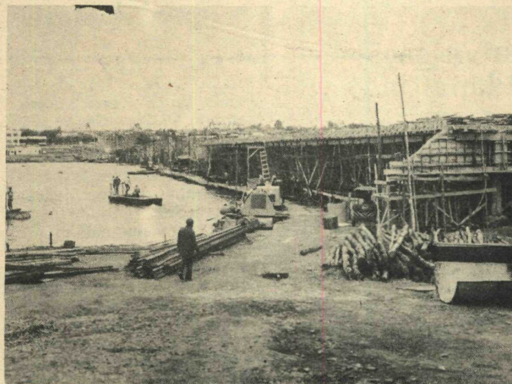
A construção da segunda ponte sobre o Lago já atingiu um terço da estrutura e oitenta por cento das fundações. Os trabalhos se realizam em regime de 24 horas por dia
