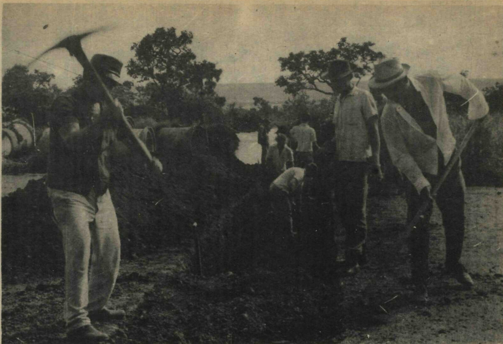
O Departamento de Águas e Esgotos está instalando a rede de esgotos na Avenida W/3 Norte. Na foto observam-se escavações onde estão sendo colocadas as manilhas que farão a interligação com o coletor-geral de esgotos da Asa Norte.
