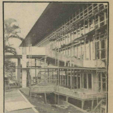
Novo edifício quase concluído
