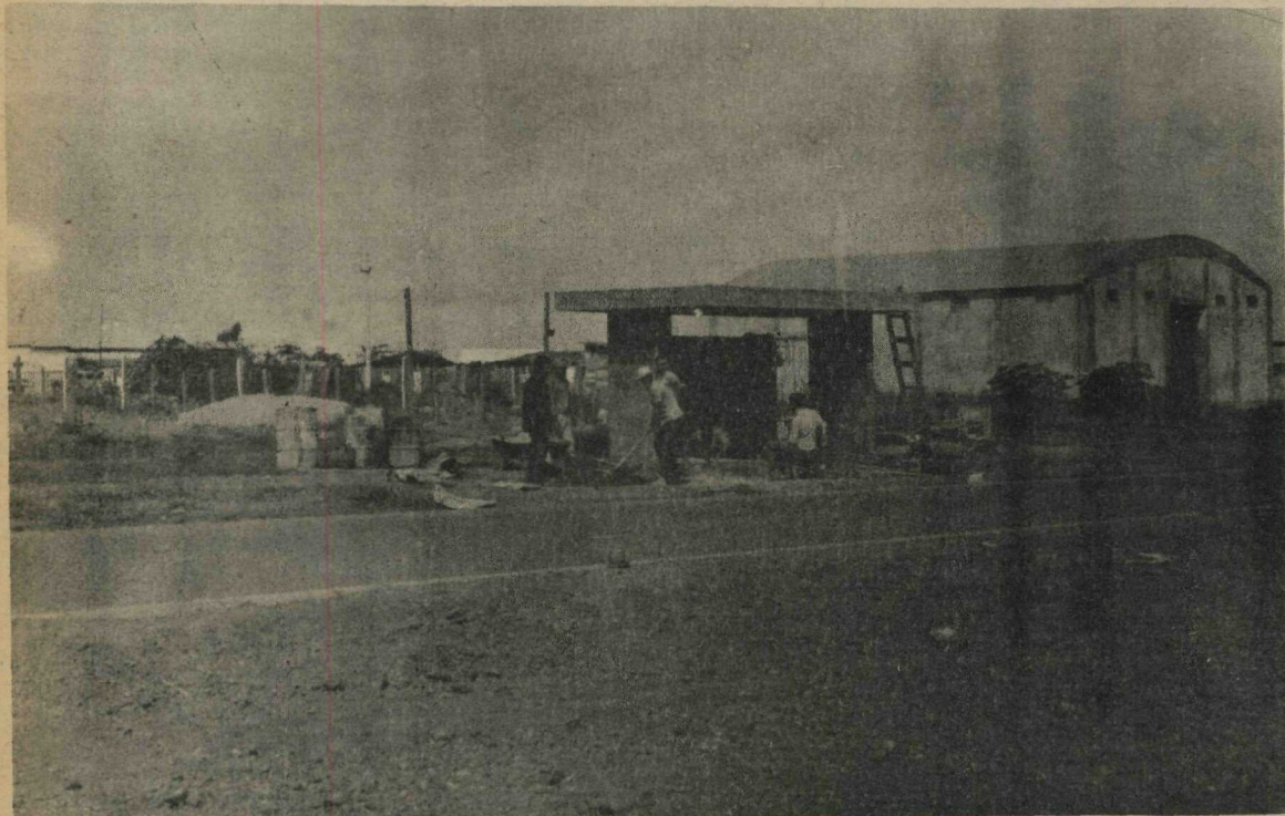
Dezesseite novos abrigos de ônibus estão sendo construídos em Sobradinho, oferecendo condições de conforto aos moradores da cidade.
