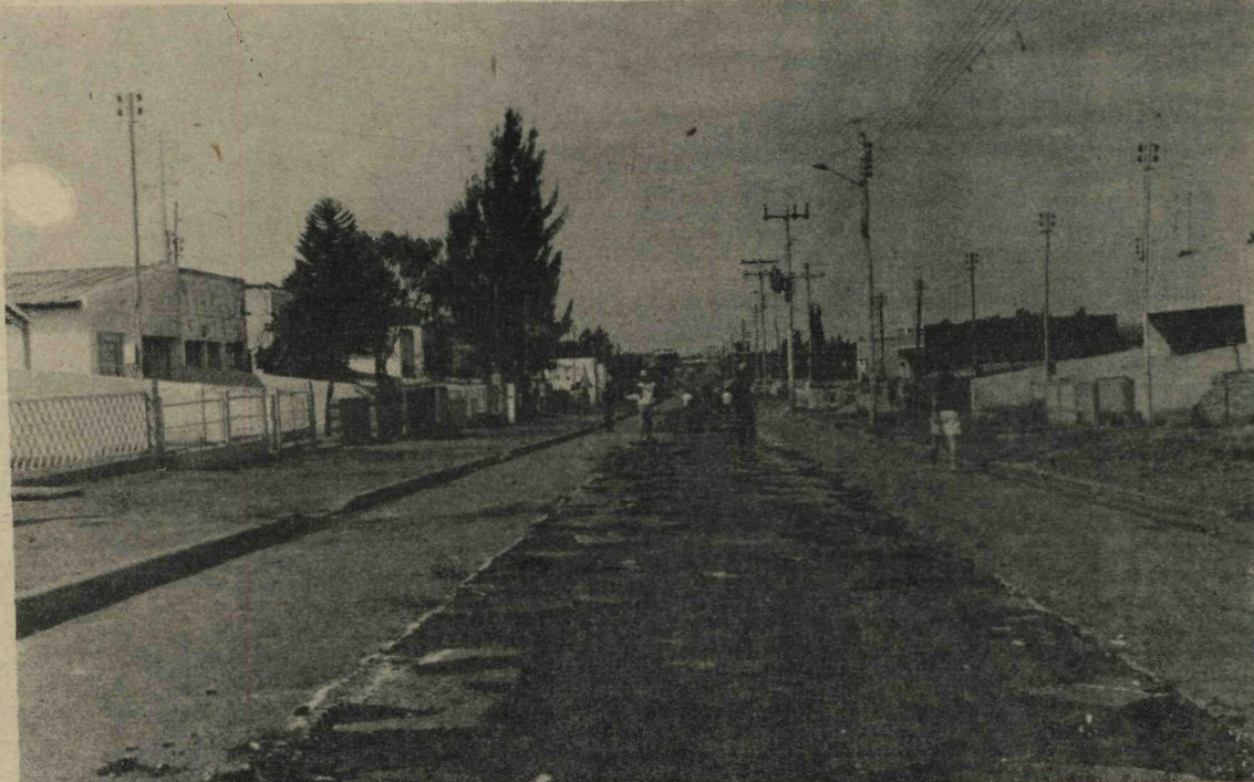
GDF ACELERA OBRAS EM TAGUATINGA - Em continuidade ao programa de trabalho da Administração Prates da Silveira, que estabelece total apoio às cidades-satélites do Distrito Federal, o Departamento de Viação e Obras da NOVACAP acelera as obras de recuperação de quatro mil metros quadrados de asfalto nas ruas de Taguatinga. Também nessa cidade-satélite está sendo construído o trevo no cruzamento da Avenida Comercial e a estrada de acesso à Ceilândia. Essas obras, orçadas em 270 mil cruzeiros, foram iniciadas na semana passada
