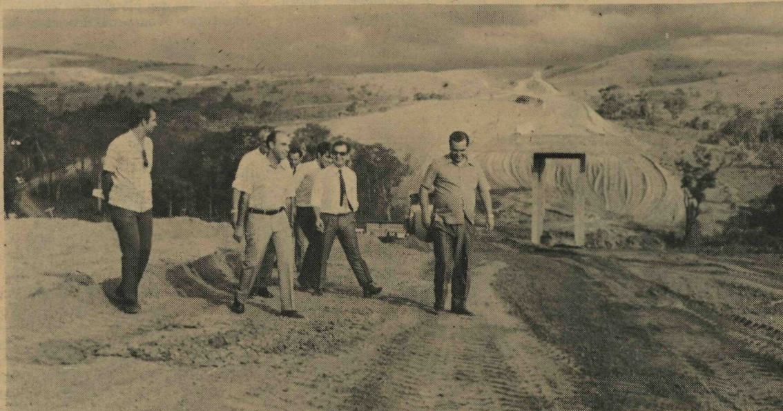
OBRAS RODOVIÁRIAS - O Governador Hélio Prates da Silveira, acompanhado de Assessores e do Diretor-Geral do Departamento de Estradas de Rodagem do Distrito Federal, Engenheiro Cláudio Diniz Starling percorreu as obras de pavimentação da Rodovia DF8 e de implantação da DF-20. A conclusão das obras dessas duas estradas está prevista para dentro dos próximos 180 dias. A visita durou mais de três horas, detendo-se o Governador em indagações e troca de impressões com o Diretor do DER-DF. A Rodovia DF-8 ligará a Estrada Parque do Contorno ao Rio Descoberto, enquanto a DF-20 ligará a BR-40 à BR-60
