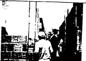
Edificação em construção. Chácara 33 N.R. Taguatinga
