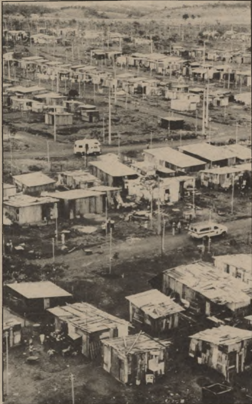
O novo núcleo habitacional será beneficiado com obras e projetos sociais
