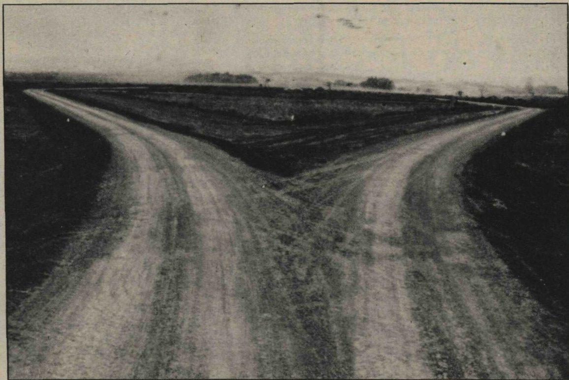
Trabalho consistirá na colocação de bueiros, cascalhamento e compactação do solo
