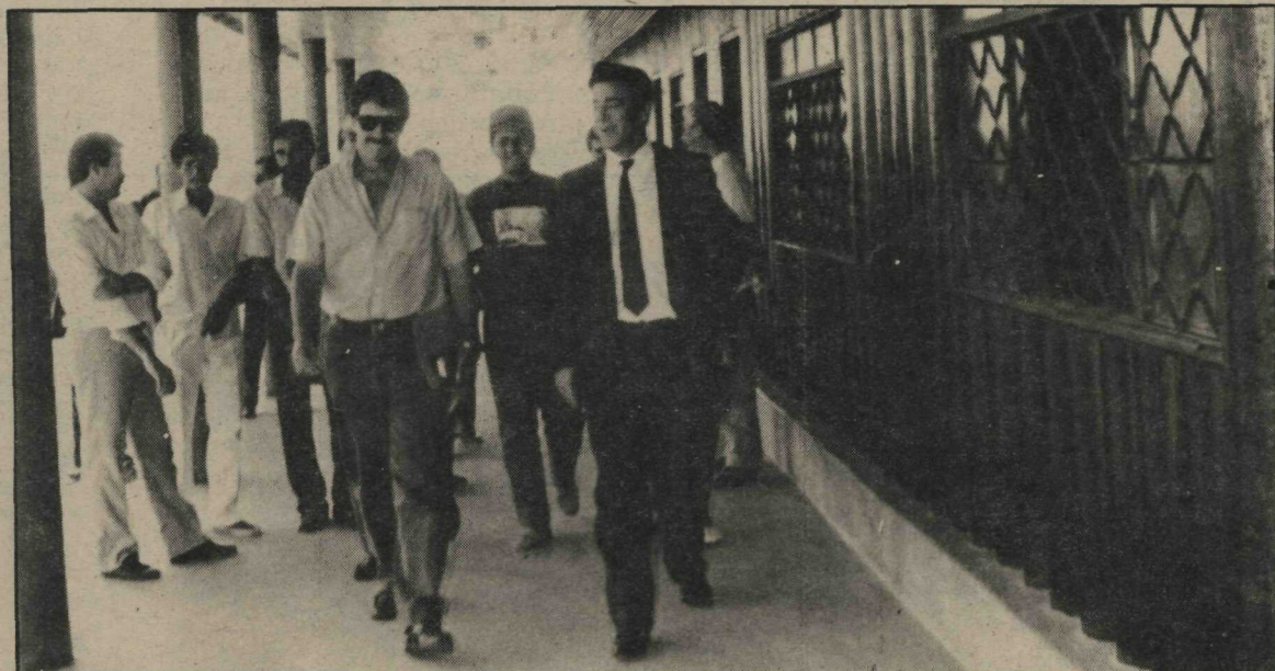
O governador Wanderley Vallim em visita a novas construções no Plano Piloto
