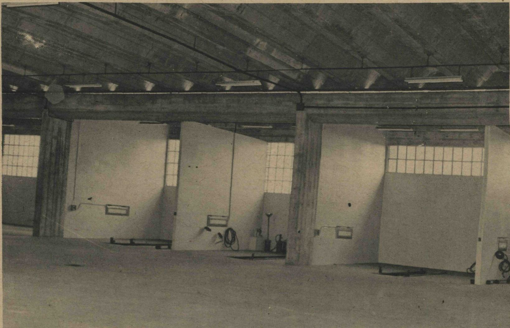
"Boxes" para lavagem e lubrificação de veículos da PDF, nas instalações da nova garagem a ser inaugurada pela Coordenação do Sistema de Transportes, da Secretaria de Administração.
