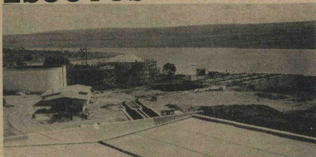
Estão continuando em ritmo acelerado as obras da Estação de Tratamento de Esgotos da Asa Norte do Plano Piloto de Brasília.
