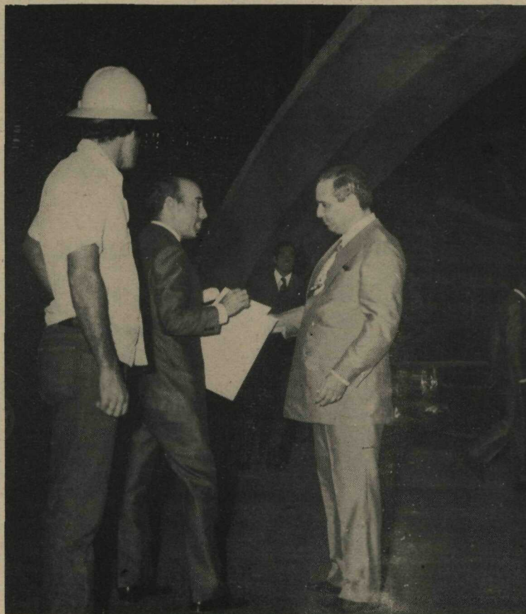
O Governador Hélio Prates da Silveira examinou detidamente, em companhia do Diretor do DER-DF, Engenheiro Cláudio Roberto Diniz Starling, as obras finais das arquibancadas do Autódromo
