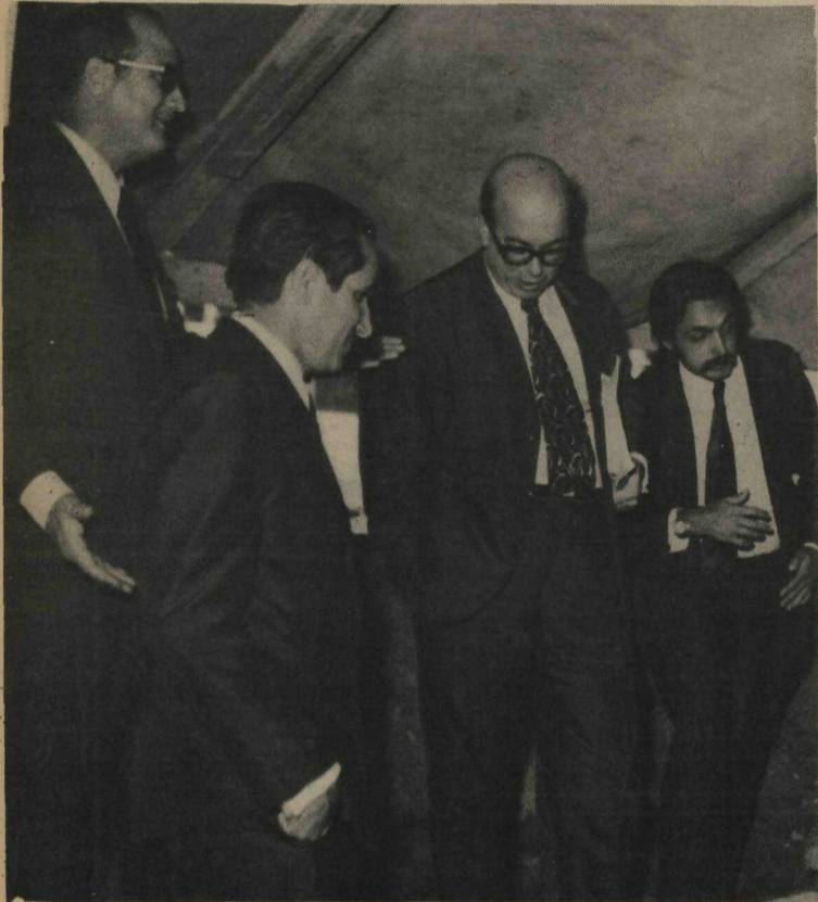
Obras de implantação de redes definitivas, realizadas pela Cotelb, foram inspecionadas pelo Secretário Paulo Fonseca Viana, de Serviços Públicos, e pelo Presidente da Companhia de Telecomunicações de Brasília, Sr. Nelson Souto Jorge, que se fazia acompanhar de Assessores
