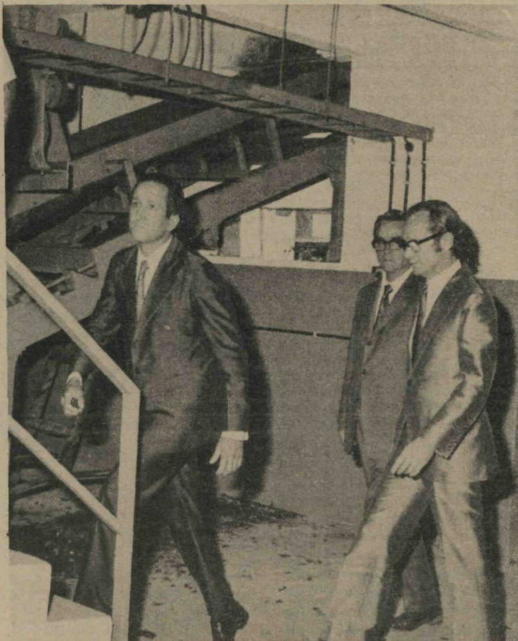
O Secretário Paulo Fonseca Viana, em companhia do Chefe do Gabinete da Secretaria de Serviços Públicos e do Diretor do SLU, visitou as instalações da nova Usina de Tratamento de Lixo
