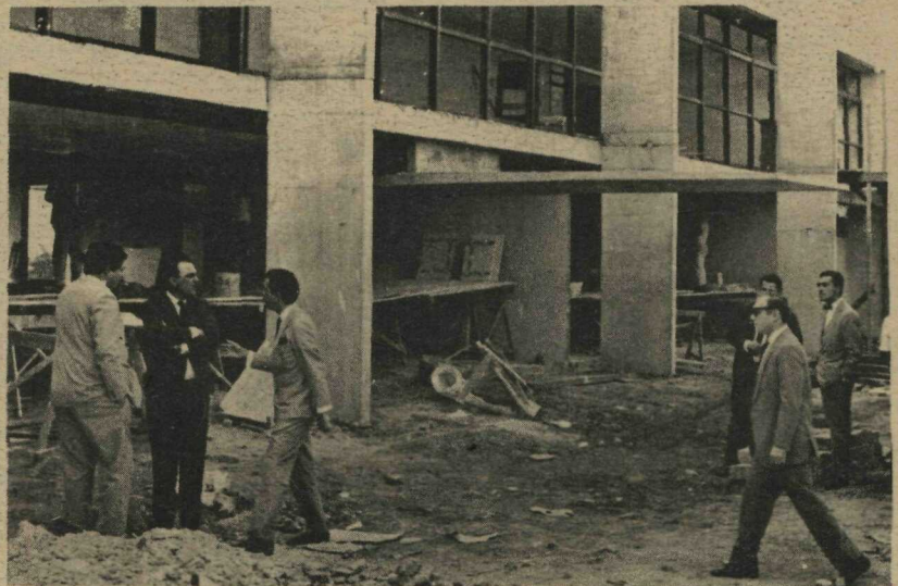
Centro Médico Psico-Pedagógico que está sendo construído na Av. W-3 Norte e que terá suas obras concluídas brevemente.
