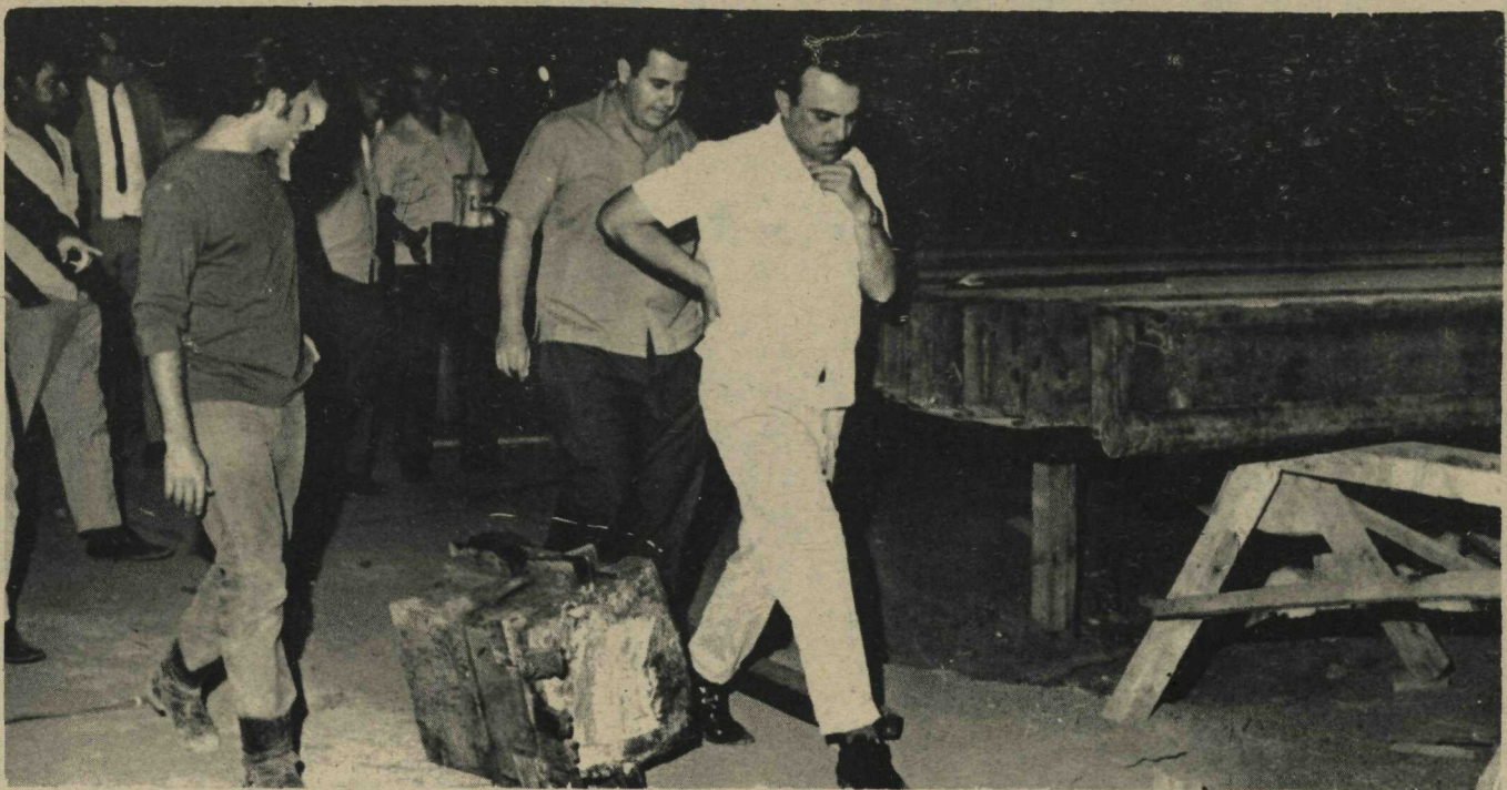
Prefeito visita Ponte - O Prefeito Wadjô Gomide realizou, às 21 horas de anteontem uma visita de inspeção às obras da ponte sobre o Lago, às quais foi imprimido ritmo acelerado, processando-se os trabalhos dia e noite. O Prefeito do Distrito Federal, que se fazia acompanhar dos Srs. Silvio Jaguaribe, Superintendente da NOVACAP e Lúcio Gomide, Superintendente da CAESB, demorou-se por cerca de três horas na obra, assistindo à colocação de uma das 36 estacas, cada uma das quais tem 24 metros de comprimento. Os engenheiros da firma encarregada da construção da ponte reafirmaram ao Prefeito que ela estará pronta dentro do prazo previsto, devendo sua inauguração ocorrer dia 21 de abril de 1970.
