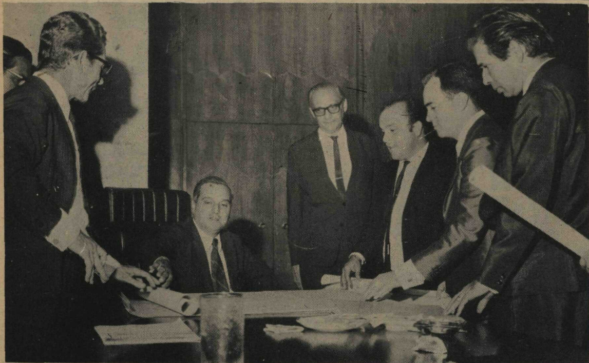
CENTRO ESPORTIVO E GINÁSIO EM BRASLÂNDIA - Serão iniciados esta semana os serviços de terraplenagem para a construção de um campo de futebol e uma piscina na cidade-satélite de Braslândia, primeira etapa do futuro Centro Esportivo local. O projeto será desdobrado em várias etapas, a longo prazo, servindo para atender as atividades esportivas do ginásio que será construído em área de 3.600 metros quadrados. O campo de futebol terá capacidade para 12 mil espectadores sentados e 4 mil em pé. O projeto foi apresentado ao Governador Hélio Prates da Silveira (foto), pelo Administrador Regional de Braslândia, Sr. Harolton Moisés Vieira Ferreira, e pelo Arquiteto Mauro Barbosa, autor do trabalho, em presença do Secretário Joio Gomes da Silva, do Governo, e do Sr. Silvano Bonfim, Coordenador da Administração Regional.
