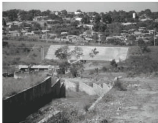
Reforço do talude do bueiro da DF-290 executado pelo DER-DF (05/2008)
