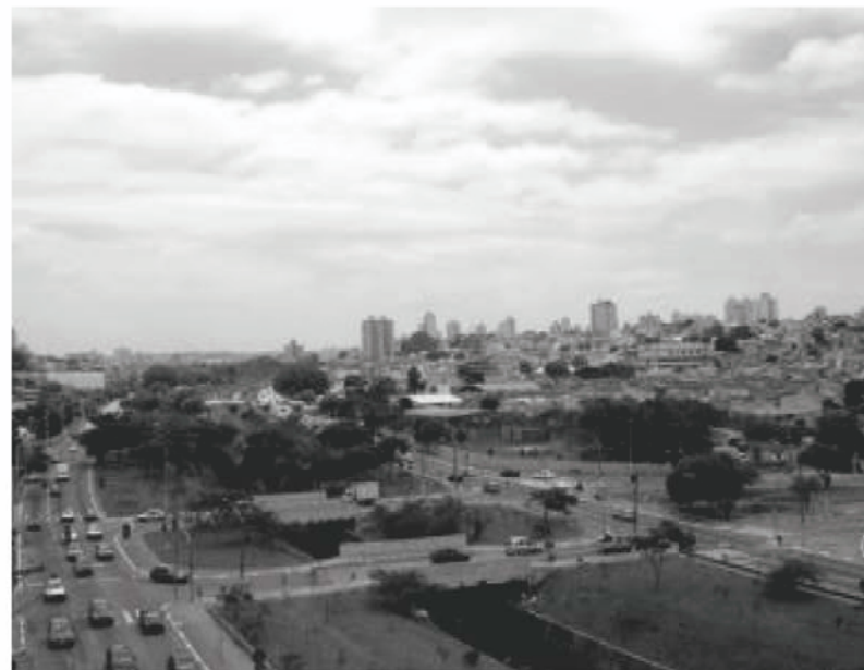
Figura 4 - Canal de Drenagem em Tiquatira-SP
